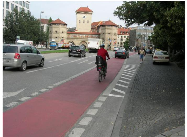
Die Wunschvorstellung des ADFC für die Freyastraße ist mitten im Münchner Zentrum am Isartorplatz bereits Wirklichkeit. Der Radverkehr wird auf dem Radfahrstreifen in die Geradeausspur geführt, bevor die Rechtsabbiegespur beginnt. Auf den Radweg rechts neben der Fahrbahn kann zugunsten einer größeren Fahrbahnbreite verzichtet werden.
